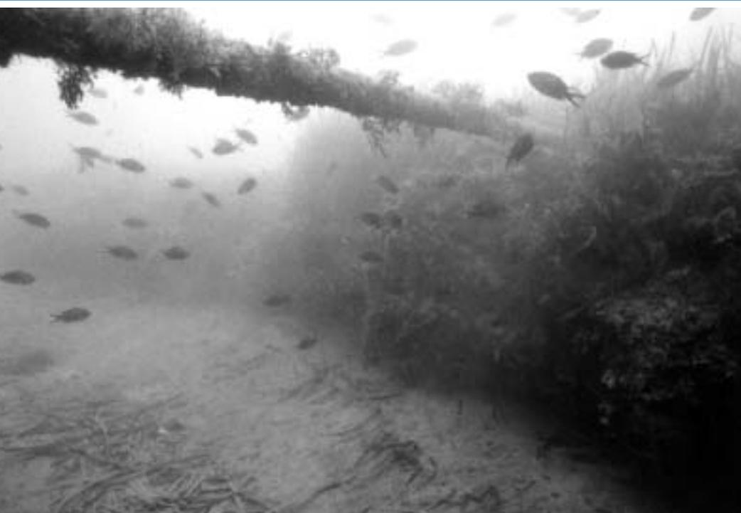
Fig. 108. Porte-à-faux d'un câble sous-marin, à Marseille (baie du Prado). Le tombant de "matte" de l'herbier à *Posidonia oceanica* est visible sur la droite. D'après Charbonnel *et al.* (1999). Photo E. Charbonnel.
