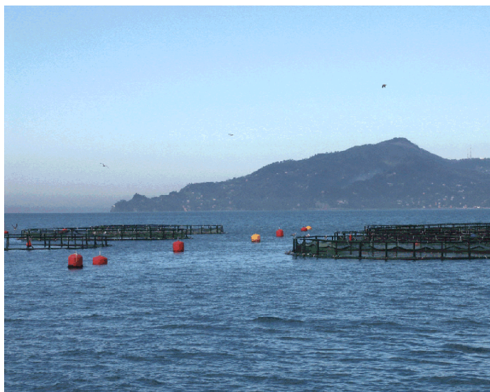
Figura 5.2: Fotografia dell'impianto con le gabbie in posizione di galleggiamento
